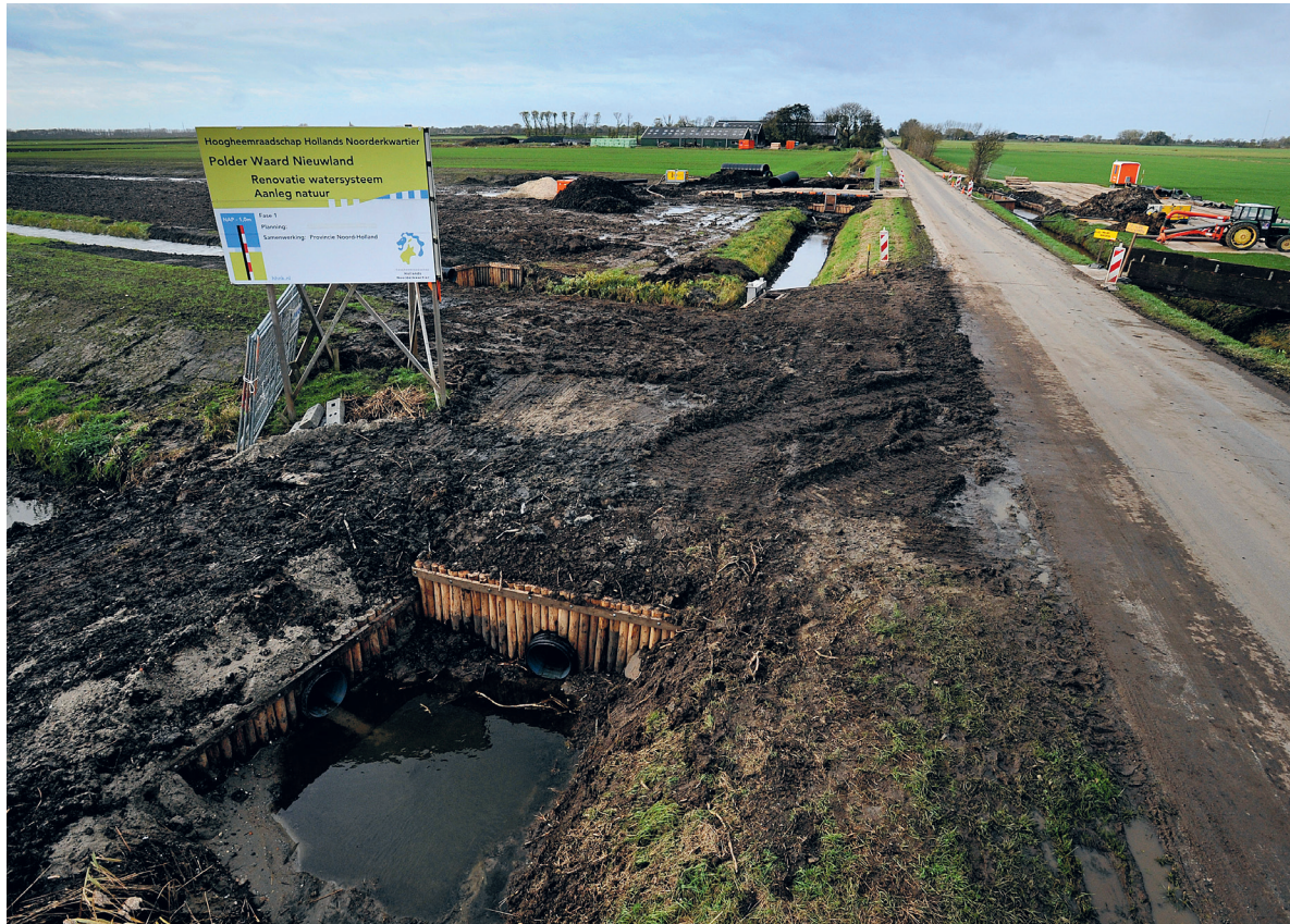
Werkzaamheden in de Polder Waard Nieuwland, een belangrijke locatie voor de herinrichting.
